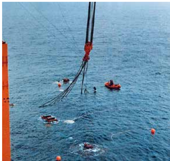
Første redningsoperasjon for å få opp stålunderstelet til DP1. Foto: Total E&P Norge A/S/Norsk Oljemuseum
