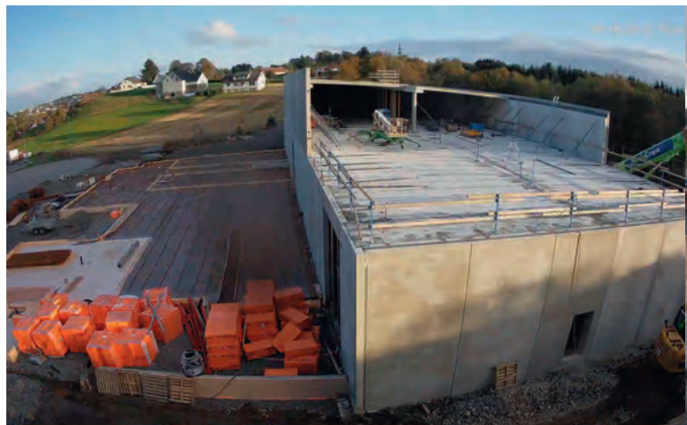
3. oktober, 2018: Elementmontasje i magasindelen. Armering av gulv i verksted og servicedelen pågår. Foto fra byggekamera
