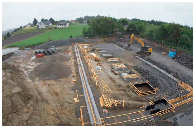
20. juni, 2018: Fundamentene til magasindelen er støpt. Fylling av bærelagsmasser til gulvet pågår. Foto fra byggekamera
