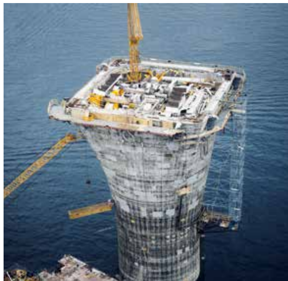
Toppen av skaffet med glideforskaling. Foto: Eivind Wolff/Norsk Oljemuseum
