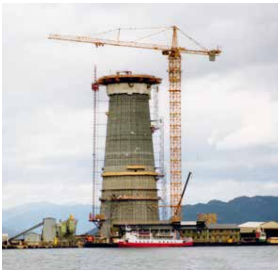
Dragen er under bygging i Yrkjefjorden i Vats, og dekkedeler som skal monteres inn i betongskaffet til plattformen ligger klar på land, før de fraktes ut med flytekran og monteres på plass. Foto: Norwegian Contractors/Norsk Oljemuseum
