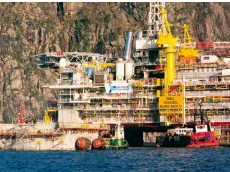
De små slepebåtene jobber på spreng for å slepe på plass de to lekterne som bærer dekket. Foto: Dag Magne Søyland/Norsk Oljemuseum
