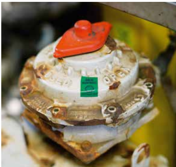
Utstyr på Draugen merket for årlig kontroll. Foto: Jan Soppeland/Norske Shell
