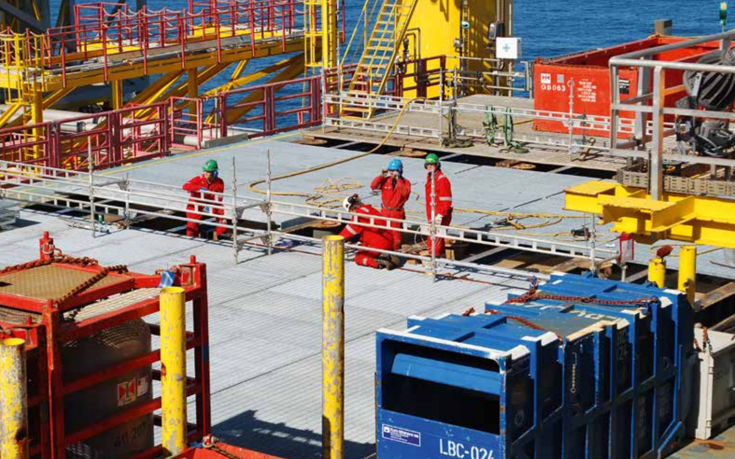
Vedlikeholdsarbeid på Draugen fotografert i 2008. Foto: Norske Shell/Norsk Oljemuseum
