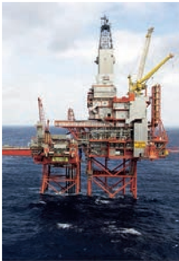
Brønnhodeplattformen Valhall WP til venstre og injeksjonsplattformen Valhall IP til høyre. Foto: BP Norge AS
