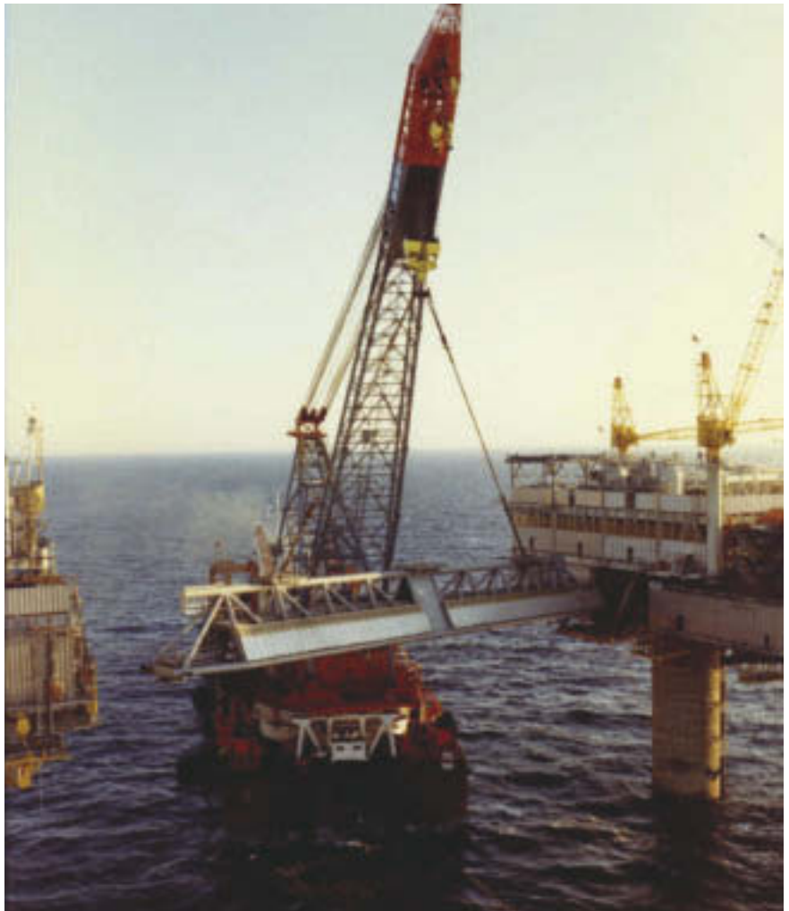
Installasjon av broen i august 1977. Foto: NOMs fotoarkiv.
