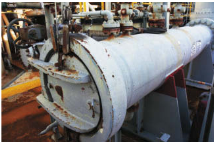
Rørskrapestasjonen på Frigg TCP2-plattformen med åpning hengslet i front. Foto: NOM/Jan A. Tjemsland.
