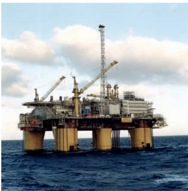
Åsgard B. Photo: Øyvind Hagen/Statoil
