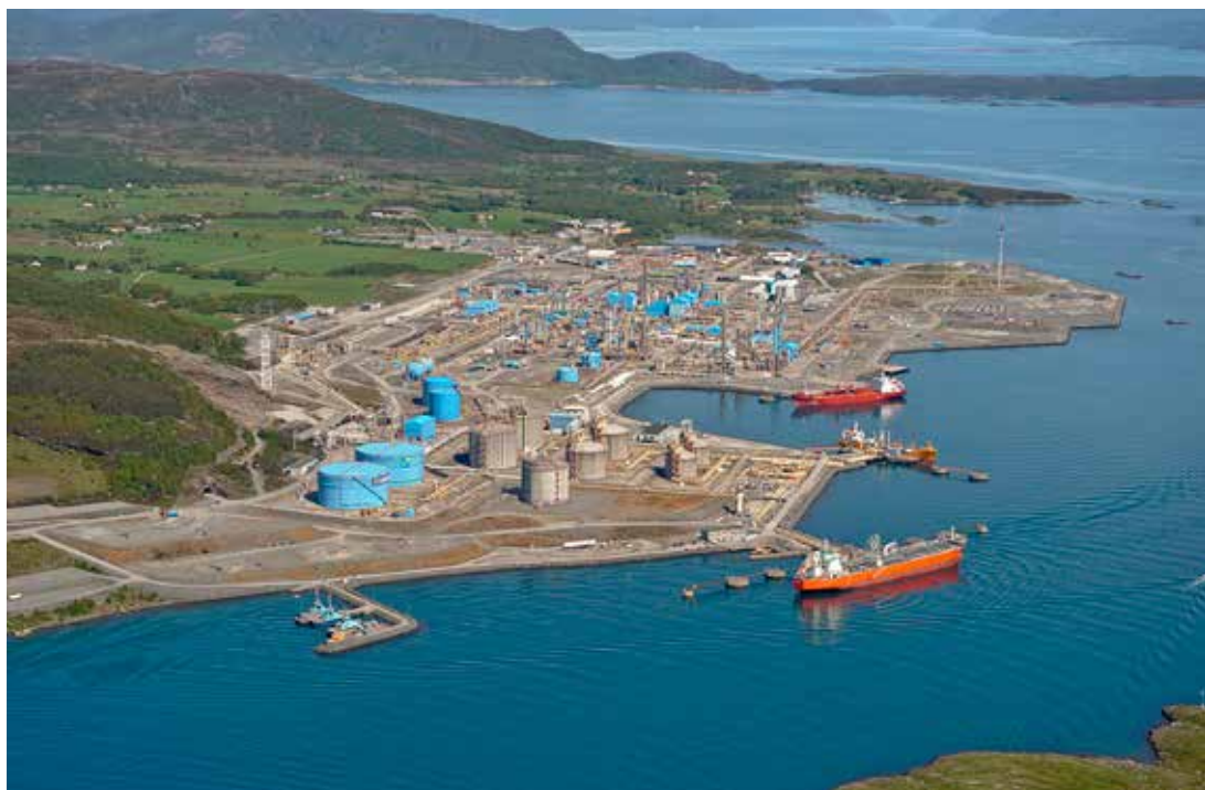
Prosessanlegget på Kårstø i Rogaland har tatt i mot mye gass fra Statfjord. Foto: Øyvind Hagen/ Statoil
