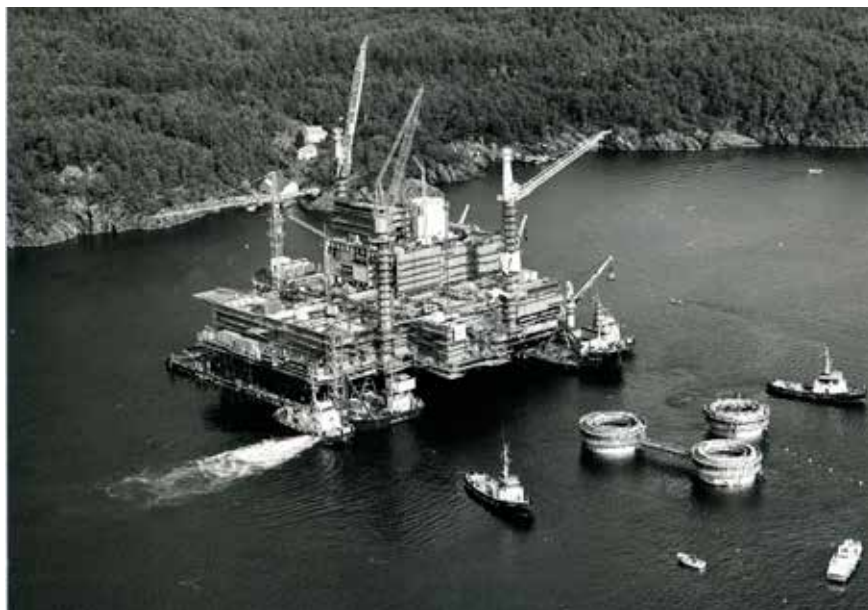
Dekket taues mot betongunderstellet for sammenkobling. Foto: Aker/NOM
