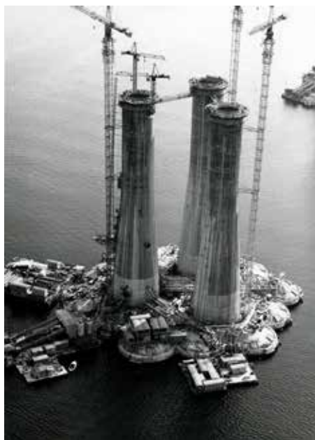
De tre skaftene er ferdig støpt. Sementblandeverket kan ses nede i venstre hjørne.
