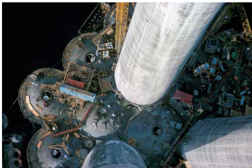
Arbeid på toppen av cellene på Statfjord A. Foto: NC/NOM
