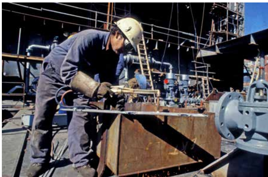
Sveising på Statfjord A. Foto: Aker Mek. verksted/NOM
