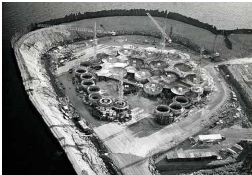
Stålskjortene blir satt på plass i byggedokken i Hinnavågen.
