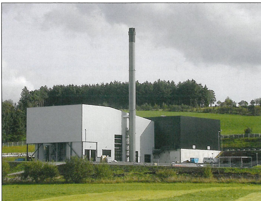
Elkraft og varme fra søppel. Totalt produserer anlegget 90 GWh, nok til en by på Egersunds størrelse.
