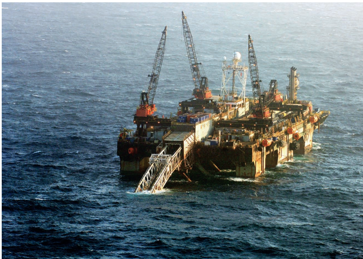
Rørleggingsfartøyet Acergy Piper. Foto: Marit Hommedal/Statoil
