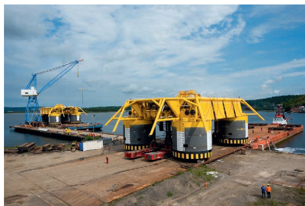
Bygging av brønnrammer til Ormen Lange. Foto: Norsk Hydro
