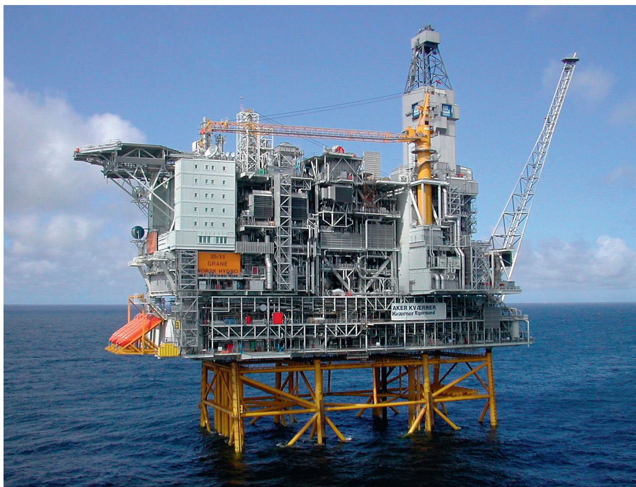
Graneplattformen med stålunderstell. Foto: Norsk Hydro
